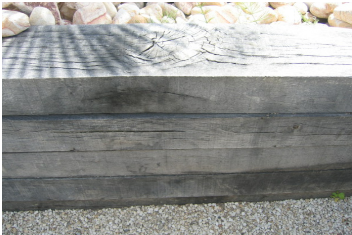
Traverse de chemin de fer
