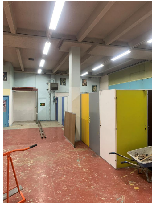
Construction de la base vie
