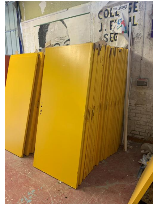
Mise en peinture sur site
