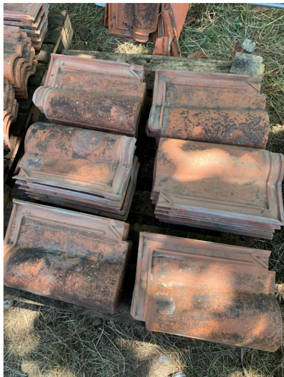
1) Dépose manuelle des tuiles
